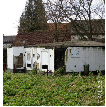
Bunker A42 te Neerhonderd in Wetteren, opgetrokken als onderdeel van het Bruggenhoofd Gent. De verdedigingslinie werd tussen 1934 en 1938 aangelegd ten zuiden van Gent ter verdediging van het nationaal reduit
