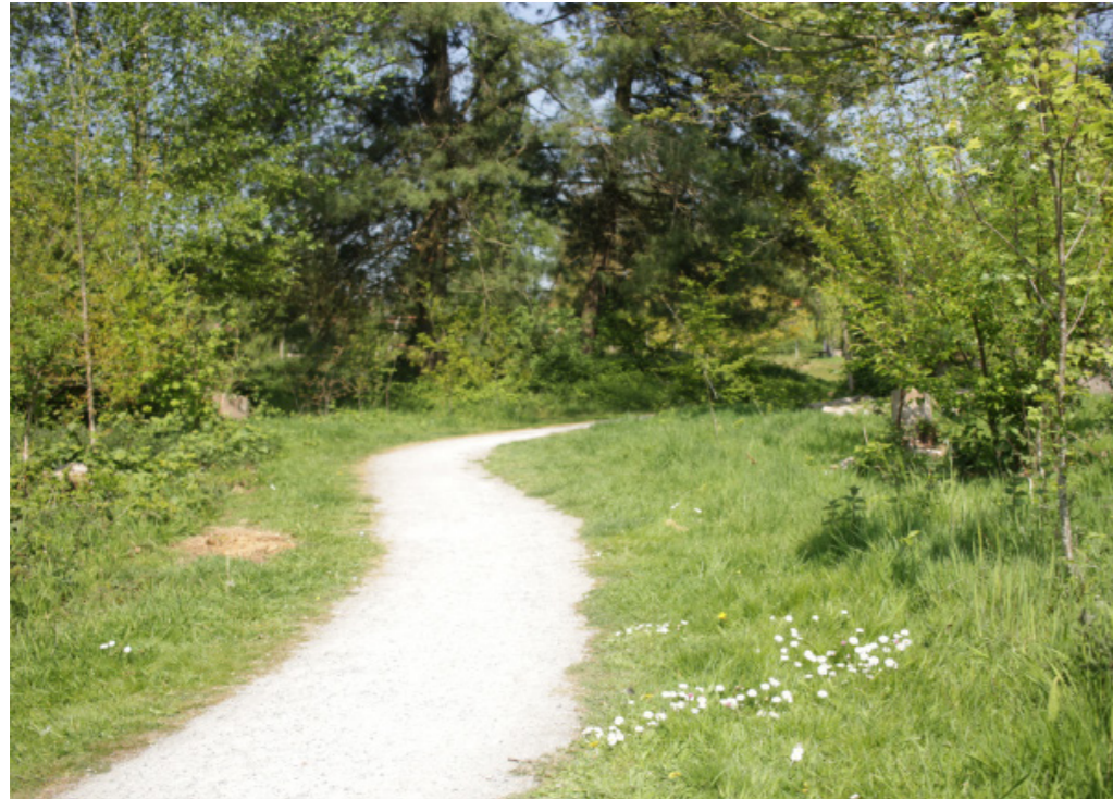
hoofdpad in halfverharding
