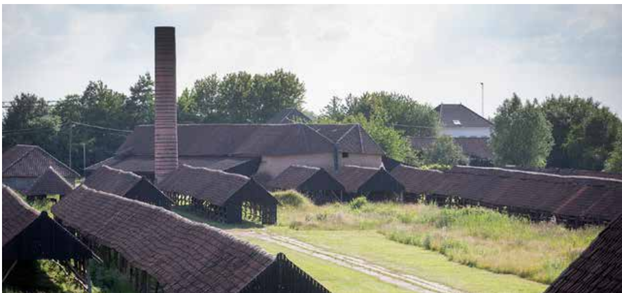
Voormalige steenbakkerij in de arbeiderswijk Noeveren in Boom. Site Frateur, museum 't Geleeg. Foto: David Samyn
