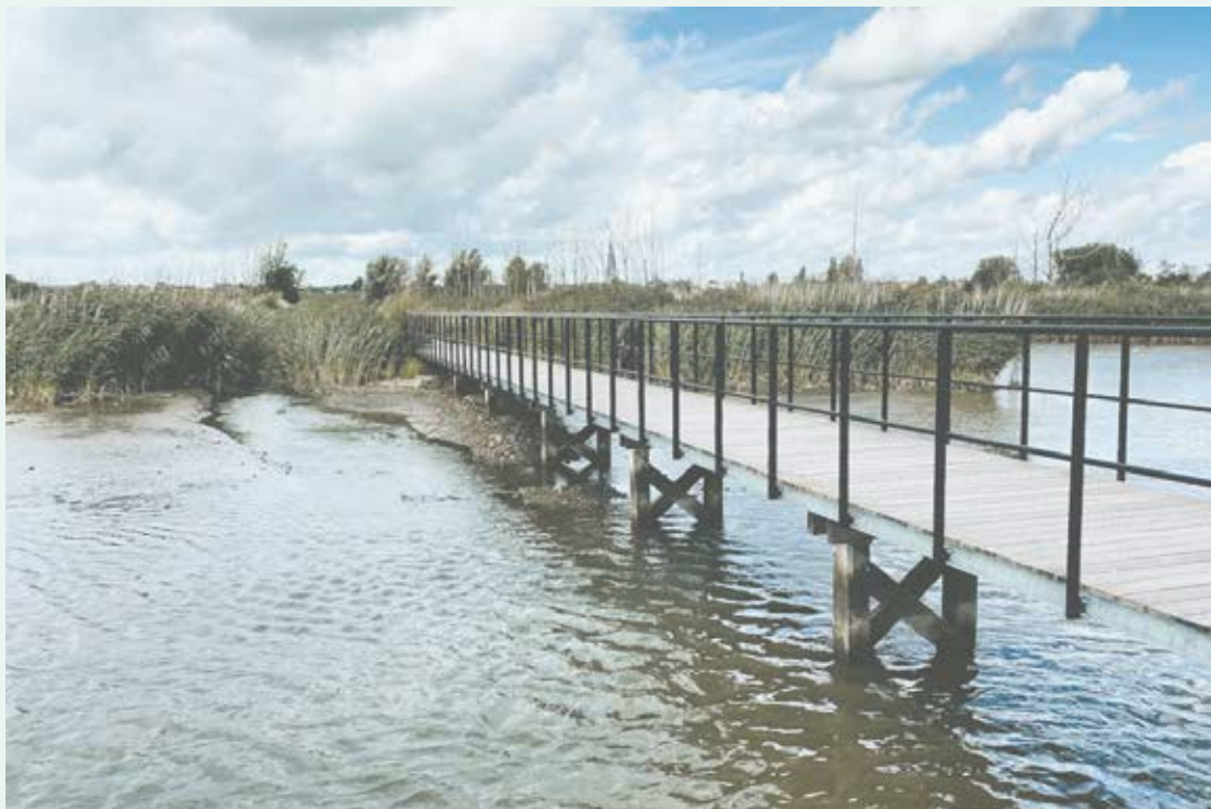
brug wandelaars en fietsers
