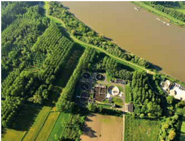
Waterzuiveringsstation aan de Schelde - Schousselbroek in Steendorp. Foto: Yves Adams Vilda
