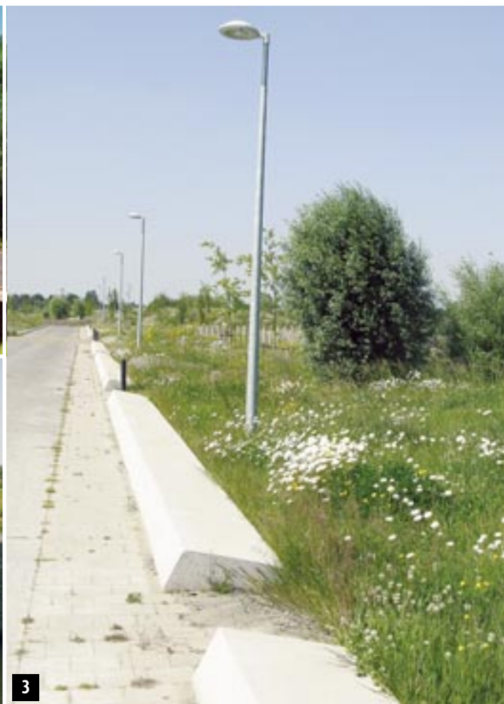
| 3 | Via openingen in de verhoogde borduur kan het regenwater rechtstreeks afvloeien in de omgeving.
