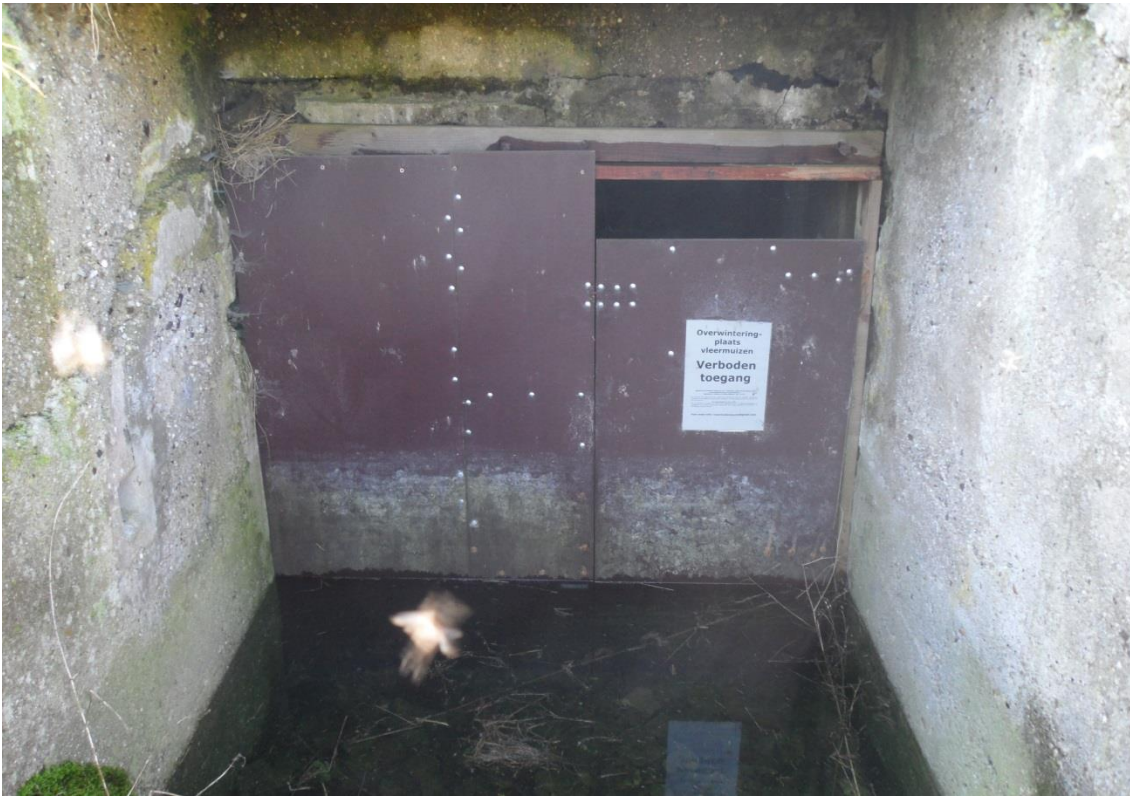
Bestaande betonplexdeur die vervangen werd.
